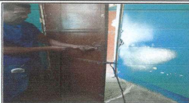
Foto 1: Cambio de chapa en la cocina de docentes
