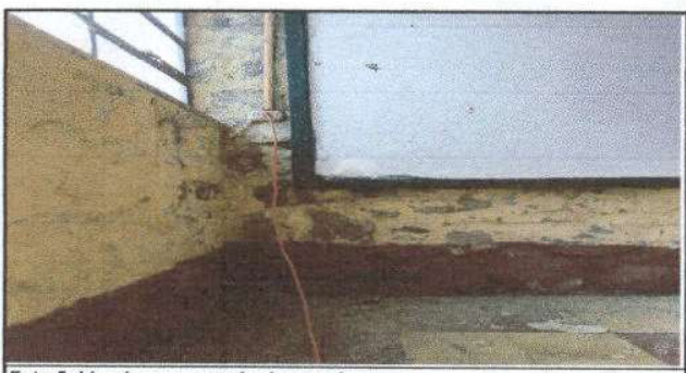
Foto 5: Limpieza y raspado de paredes
