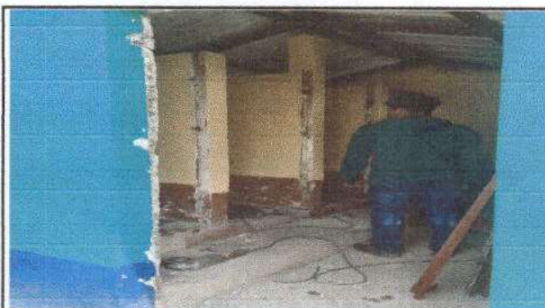
Foto 4: cambio de puertas en los baños
